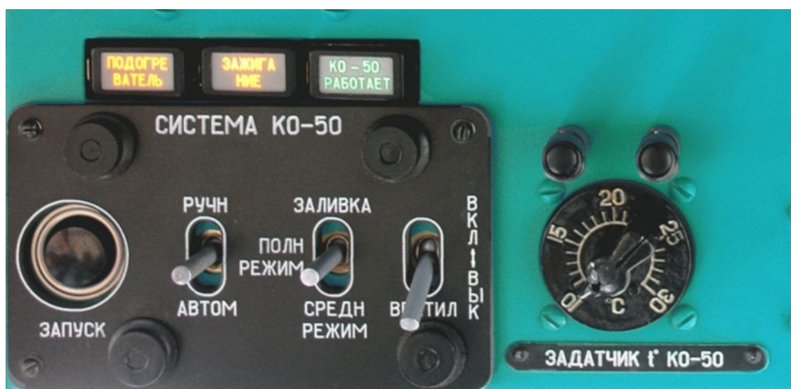
Правая панель электропульты.
